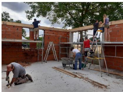
Ce lundi 1er août, la dernière étape de la consolidation du bâtiment pré-existant, avec la réalisation du chaînage en béton, a été achevée.
