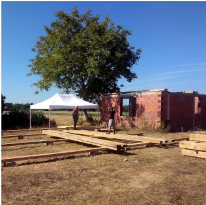
Après avoir terminé les fondations et les reprises de maçonnerie sur le bâtiment préexistant, nous avons engagé la construction de la charpente en bois du bâtiment agricole de la plaine de Lescure.
