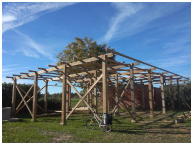
**Au chantier :** La charpente est terminée ! Les prochaines étapes sont la toiture et les fixations charpente - supports en béton...
